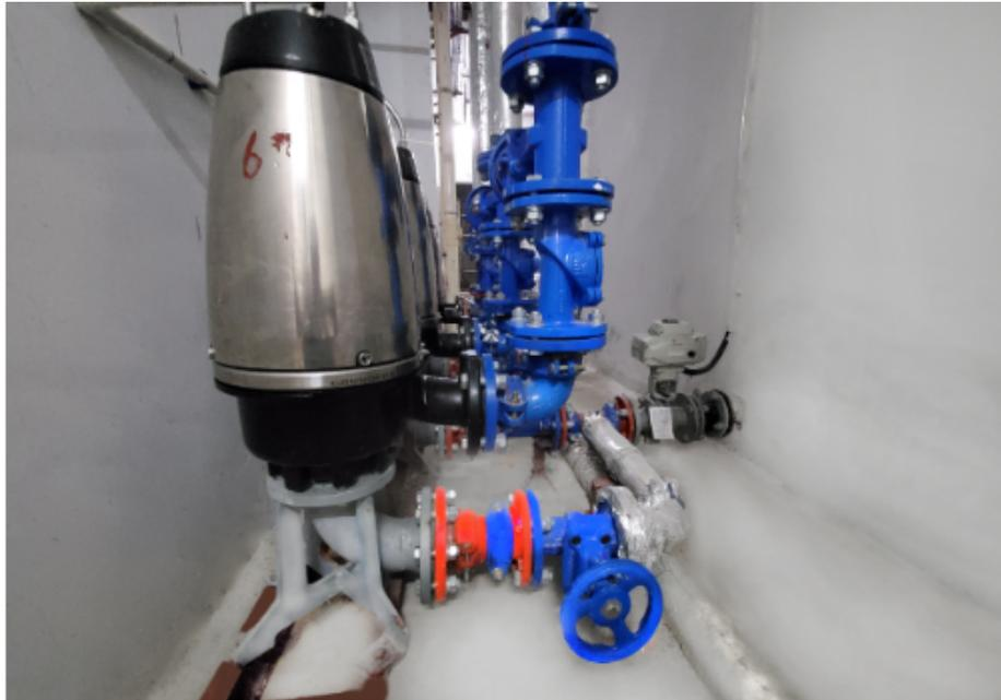
综合实验室废水处理系统：通过采用系列PCR实验室污水处理设备，当PCR实验室产生废水时可以通过污水管进行排放，污水管将废水排放到调节池内，实验室废水分批量向调节池内进行投放，废水排放到调节池之前会经过格栅的简单过滤处理，用于将废水内的杂质剔除，在调节池内可对废水首先进行中性处理，酸碱调和模块可对废水内的酸碱性调和达到平衡，在调节池内倒入酸性溶液或碱性溶液于废水内，废水从PCR实验室污水处理设备的调节池内输送到溶液混合模块中，在溶液混合模块中溶液循环搅拌单元可以对废水内的酸性溶液或碱性溶液进行充分的与废水混合。核医学处理废液的一般原则：大量的有毒气体必须通过与氧充分燃烧或吸附处理后才能排放。金华核医学废液贮存衰变处理系统哪家好
