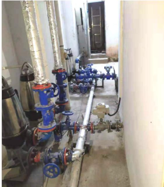
一种放射性废液自动处理排放监控系统的制作方法：一种放射性废液自动处理排放监控系统，包括外壳体、储液池、至少3个衰减池和降解池，所述至少3个衰减池和降解池安装在外壳体内，所述储液池上设置有进水口，所述储液池通过连接管道连通至降解池，所述降解池通过连接管道依次连通至各个衰减池，每个所述衰减池内的连接管道上的出液口均设置有第二电动阀，每个所述衰减池的顶部设置有排水管，所述排水管的一端连通至衰减池内，所述排水管的另一端设有排水口，所述排水管上设有一电动阀，所述一电动阀与排水口之间设有水泵。
